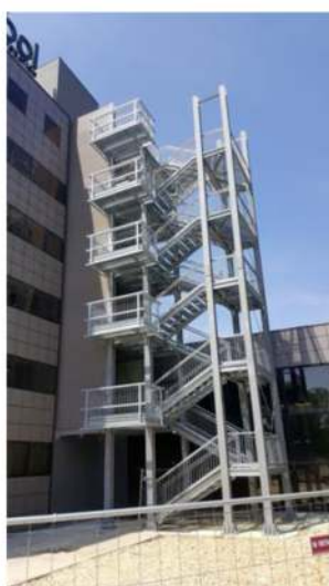
SCALA DI EMERGENZA IN COSTRUZIONE
